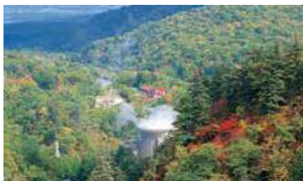
松川地熱発電所
