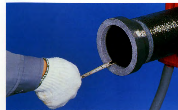
打込代の確認
