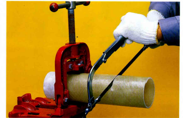
金鋸によるパイプの切断
