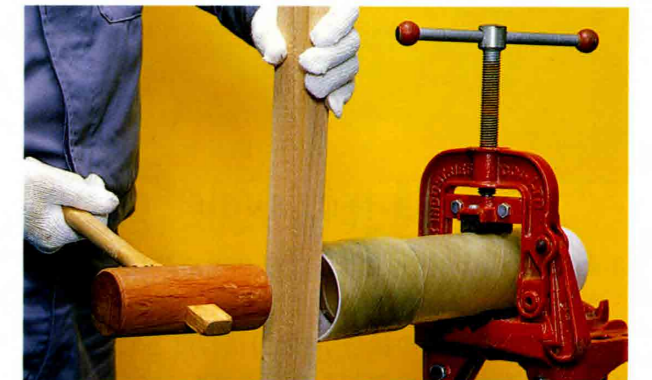
当て木を用いてソケットの打込み
