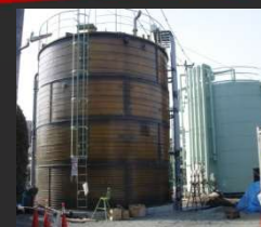
FRP製 現地組立型タンク
