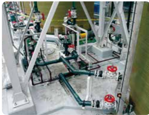
製鉄所／塩酸設備 薬液配管
