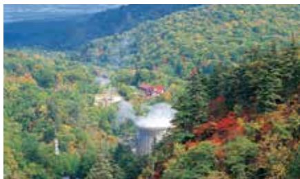
松川地熱発電所
