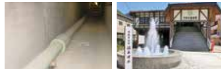
トンネル内引湯管
