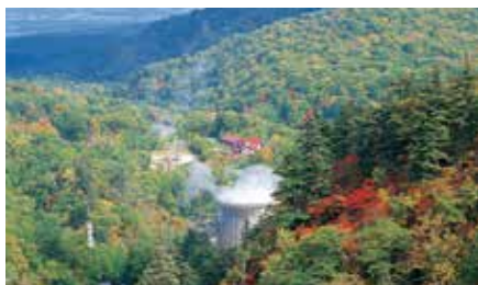
松川地熱発電所
