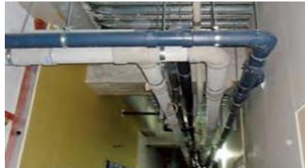
実験排水配管（フジGRPパイプ）
