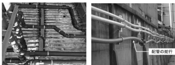
(a) 排水用フジGRPパイプ (b) ポリエチレンパイプ
